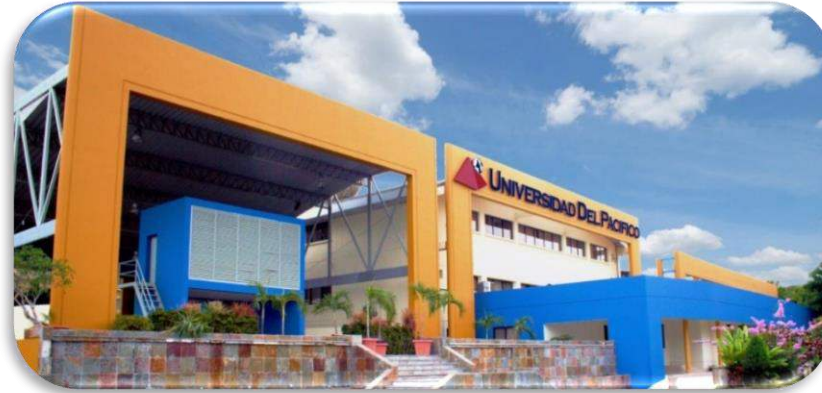
Ilustración 1. Instalaciones UPACIFICO - Campus Guayaquil
